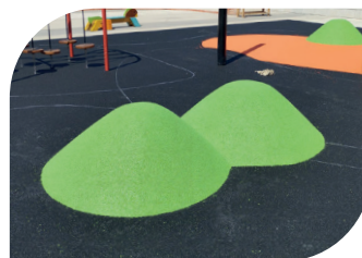
Execução da camada de amortecimento em SBR
