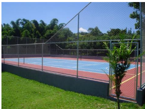
Alambrado com contenção
